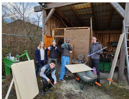
Schleiereulen-Kästen-Bau in Wistedt
